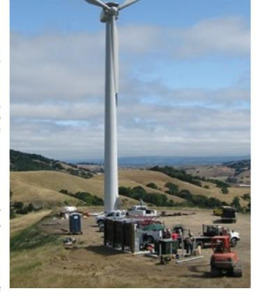
battimento dei costi di manutenzione. Quando il vento supera una certa soglia la navicella cambia il suo orientamento rispetto al vento per diminuire la portanza e mantenere la spinta del vento entro il range di sicurezza.
